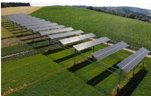
Foto placas fotovoltaicas sobre cultivo
